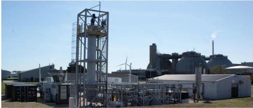
**P2G-BioCat, Danimarca** // Alcalino da 1 MW alimentato da eolico in eccesso per produrre idrogeno da immettere nella rete del gas naturale.
